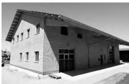
Neubau am Mühlegässli 12
