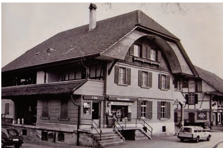
Käsereigebäude (Quelle: Bildband Hindelbank, 2014)
