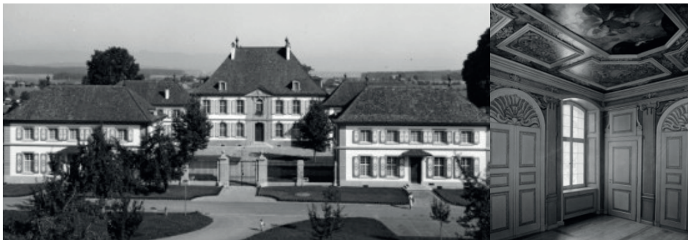
Abb. 4: Schloss Hindelbank, (kt. Denkmalpflege Bern)
